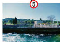
BASSIN DE TRANQUILLISATION
